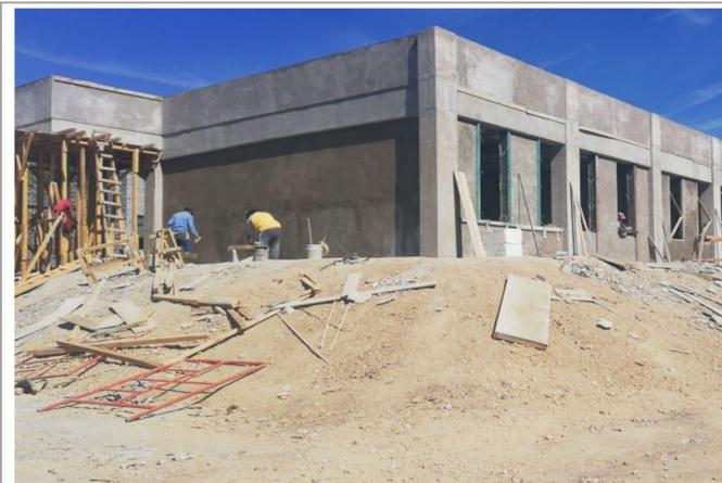
F4: Preparación de estructura para colado de concreto en losa.
