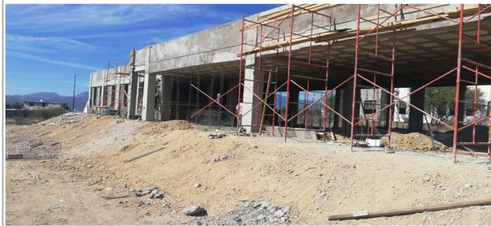
F2: Habilitado de acero, cimbrado y colado de elementos estructurales losa.
