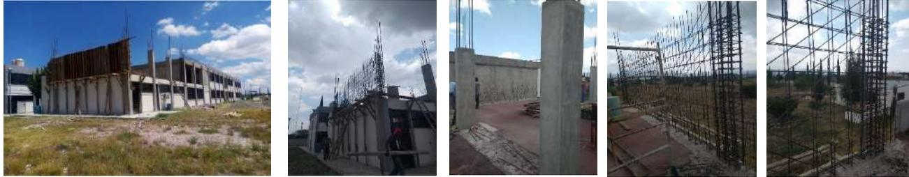
Superficie de desplante en edificio existente para construcción de aulas; demolición de concreto en losa existente para anclaje de muros y columnas de concreto armado en estructura; suministro y habilitado de acero en losa existente para desplante de muros y columnas de concreto armado.
