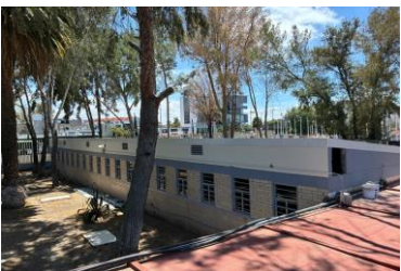
Foto: Conclusión de suministro y colocación de sobre techumbre a base de estructura metálica y lámina galvanizada; y conclusión de trabajos de sustitución de cancelerías (puertas y ventanas)
