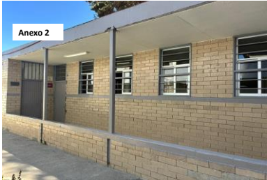
Foto: Conclusión de suministro y colocación de sobre techumbre a base de estructura metálica y lámina galvanizada; y conclusión de trabajos de sustitución de cancelerías (puertas y ventanas)
