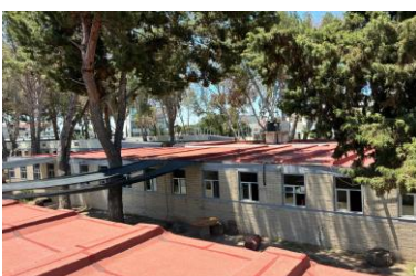
Foto: Conclusión de suministro y colocación de sobre techumbre a base de estructura metálica y lámina galvanizada; y conclusión de trabajos de sustitución de cancelerías (puertas y ventanas)
