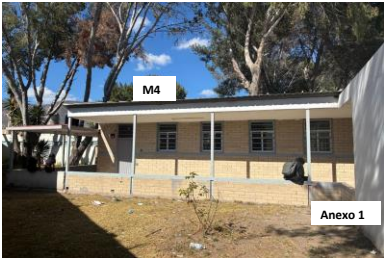
Foto: Conclusión de suministro y colocación de sobre techumbre a base de estructura metálica y lámina galvanizada; y conclusión de trabajos de sustitución de cancelerías (puertas y ventanas)
