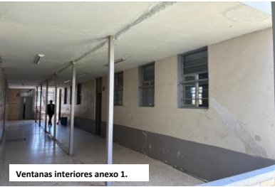
Foto: Conclusión de suministro y colocación de sobre techumbre a base de estructura metálica y lámina galvanizada; y conclusión de trabajos de sustitución de cancelerías (puertas y ventanas)
