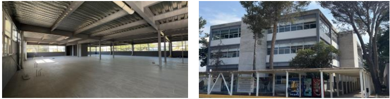
Fotos: trabajos en 2do nivel, obra concluida 31 de enero de 2026 y recepcionada. Esta obra requerirá contrato subsecuente para concluir trabajos en segundo nivel.
