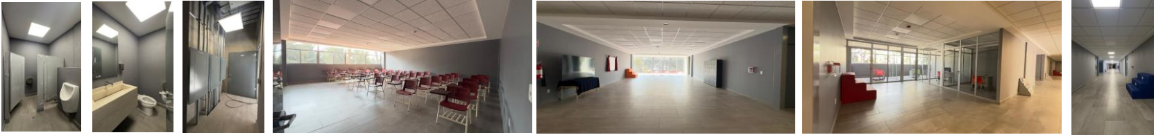
Fotos: 1er. Nivel concluido, obra recepcionada.
