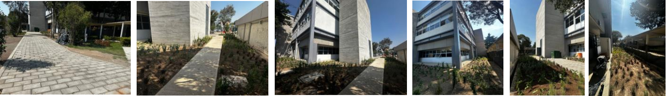
Fotos: Conclusión de trabajos en andadores, y suministro y colocación de jardinería
