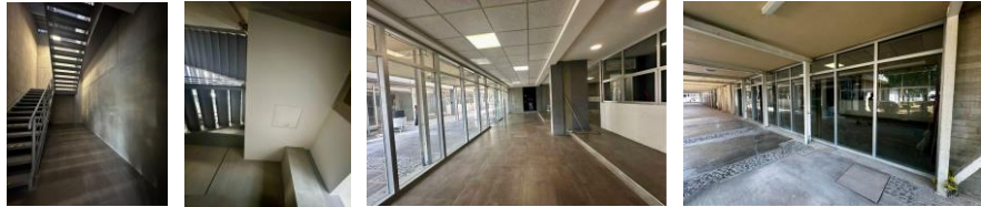
Fotos: Trabajos de albañilerías en lechos bajos y muros en cubo de escaleras; conclusión de trabajos en vestíbulo de acceso principal ( muros de tablaroca, plafones de tablaroca, pintura y cancelería).
